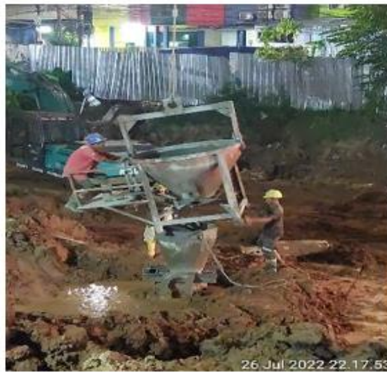
Gambar 11. Pengecoran Bucket
