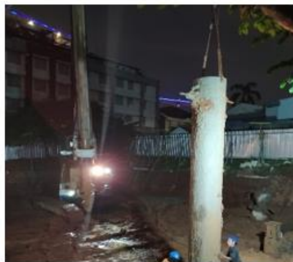
Gambar 7. Pemasangan Casing
