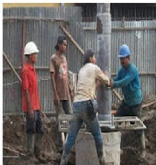
Gambar 10. Pemasangan Tremi
