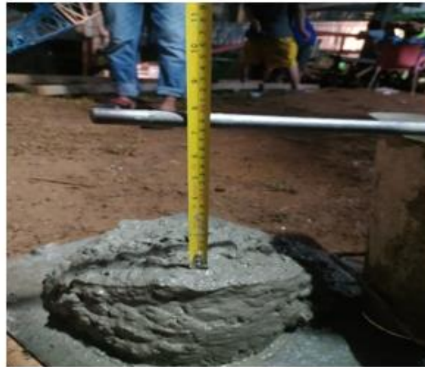
Gambar 9. Tes Slump Pengecoran
