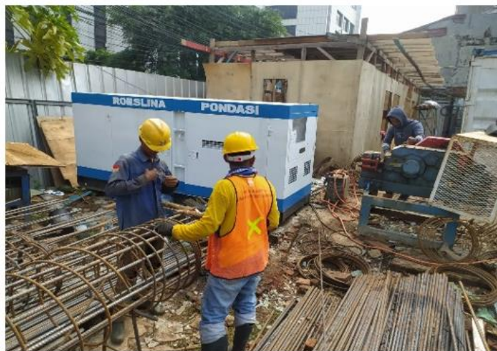
Gambar 3. Fabrikasi Pembesian
