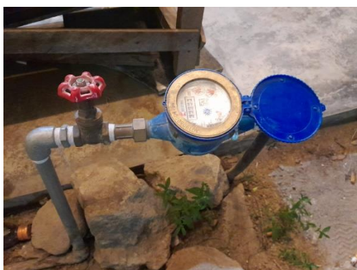
Gambar 4. Meter Air Sambungan Rumah (SR)
