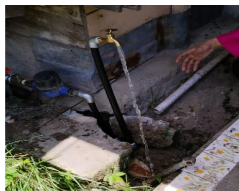
Gambar 4. Meter Air Sambungan Rumah (SR)
