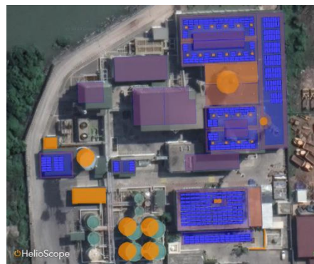
Gambar 3. Area Pemasangan Panel Pv Pt Xxx – Gresik
